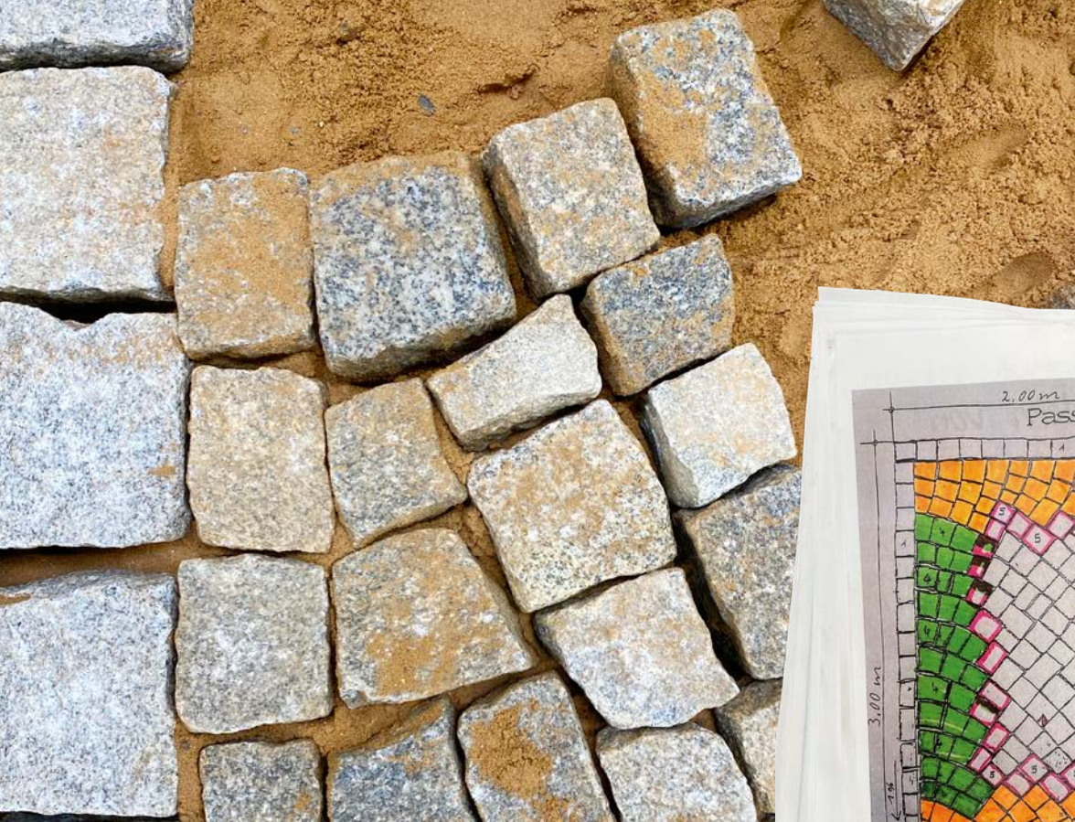
Das Verwenden von Schmiegeln – also ungleichmäßigen Steinen mit einem Winkel von 30° – als Anschluss an die Läuferzeile erspart den Pflasterern das Schlagen von Dreiecken.
